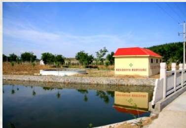
沂水镇中低产田改造水利工程
